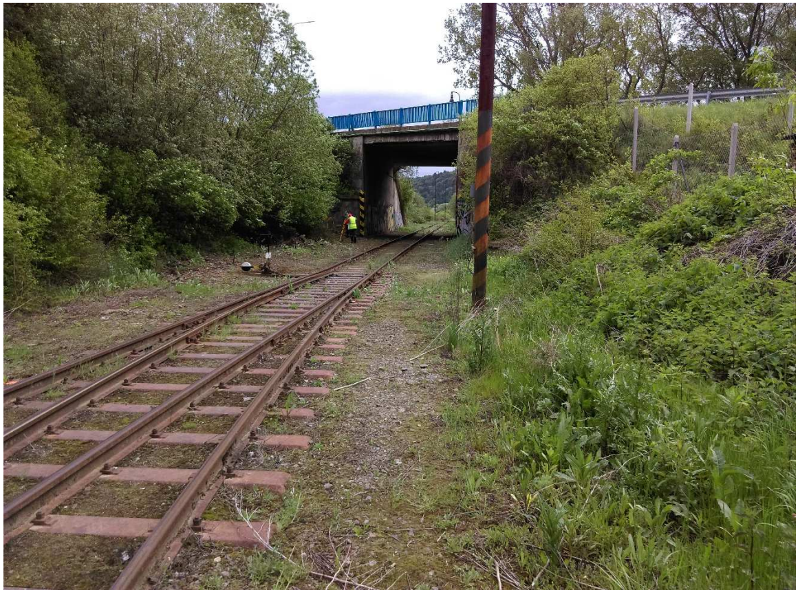
Most 68-041 cez železničnú vlečku
