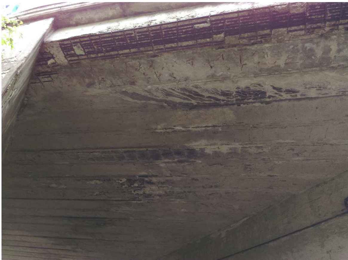
Most 68-041 cez železničnú vlečku
