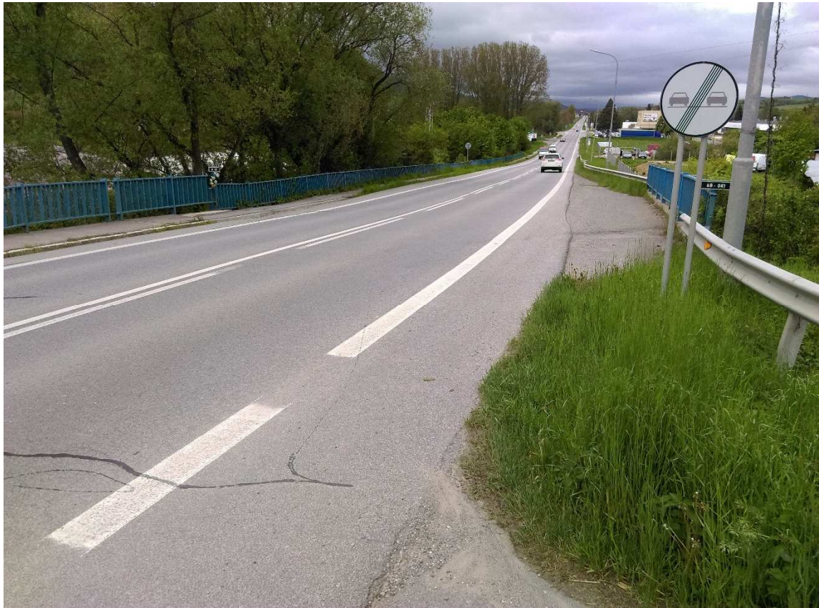
Most 68-041 cez železničnú vlečku
