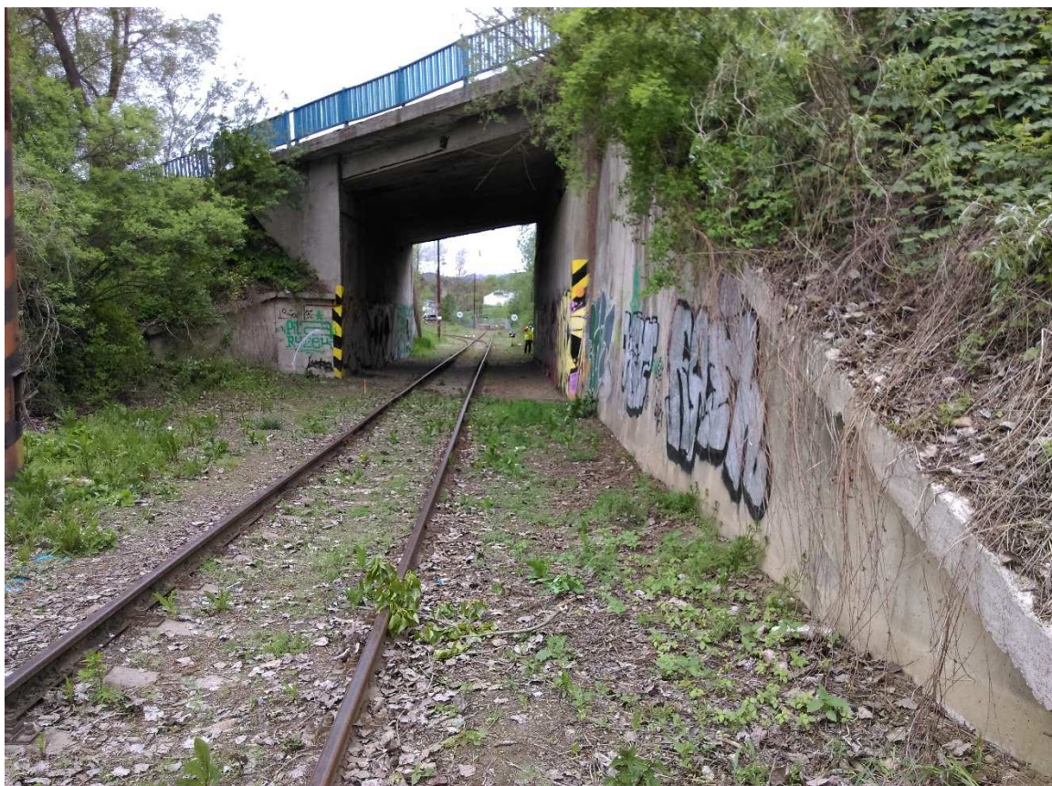
Most 68-041 cez železničnú vlečku
